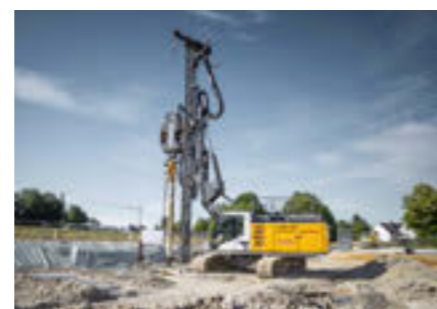
Špeciálne stroje na podzemné stavby
